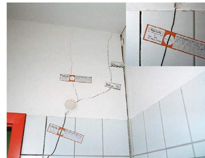
Beispiel für die Dokumentation von Rissen
