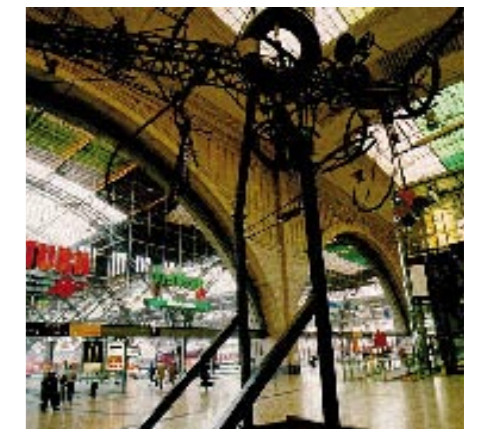
Der völlig umgebaute Leipziger Bahnhof
