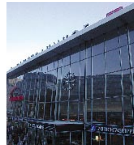
Die Collonaden in Köln – eines der Shopping-Prestigeprojekte der Bahn AG
